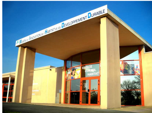
La Maison de l'Innovation de l'Habitat et du Développement Durable est ouverte depuis 2010
