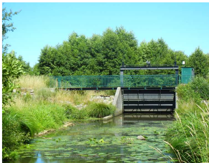
Barrage de Chécheux sur la Chère (prévention des inondations)
