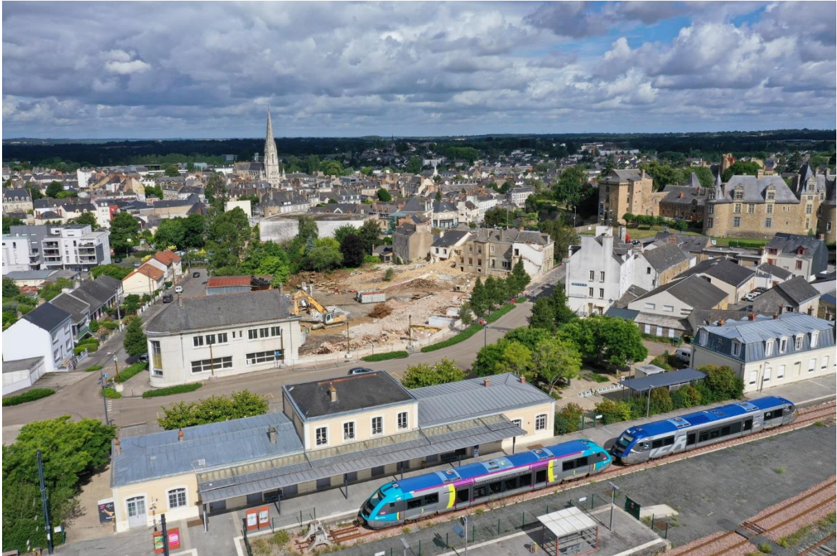
Vue du ciel – Démolitions Ilot des Terrasses
