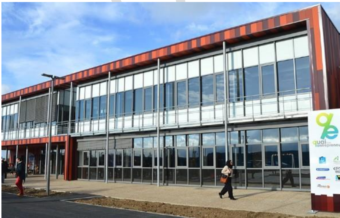
Photo du Quai des Entrepreneurs
