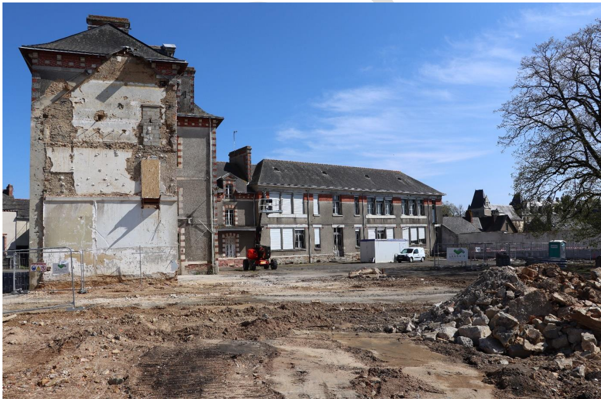
Photo – Démolitions Ex-Centre Aristide Briand
