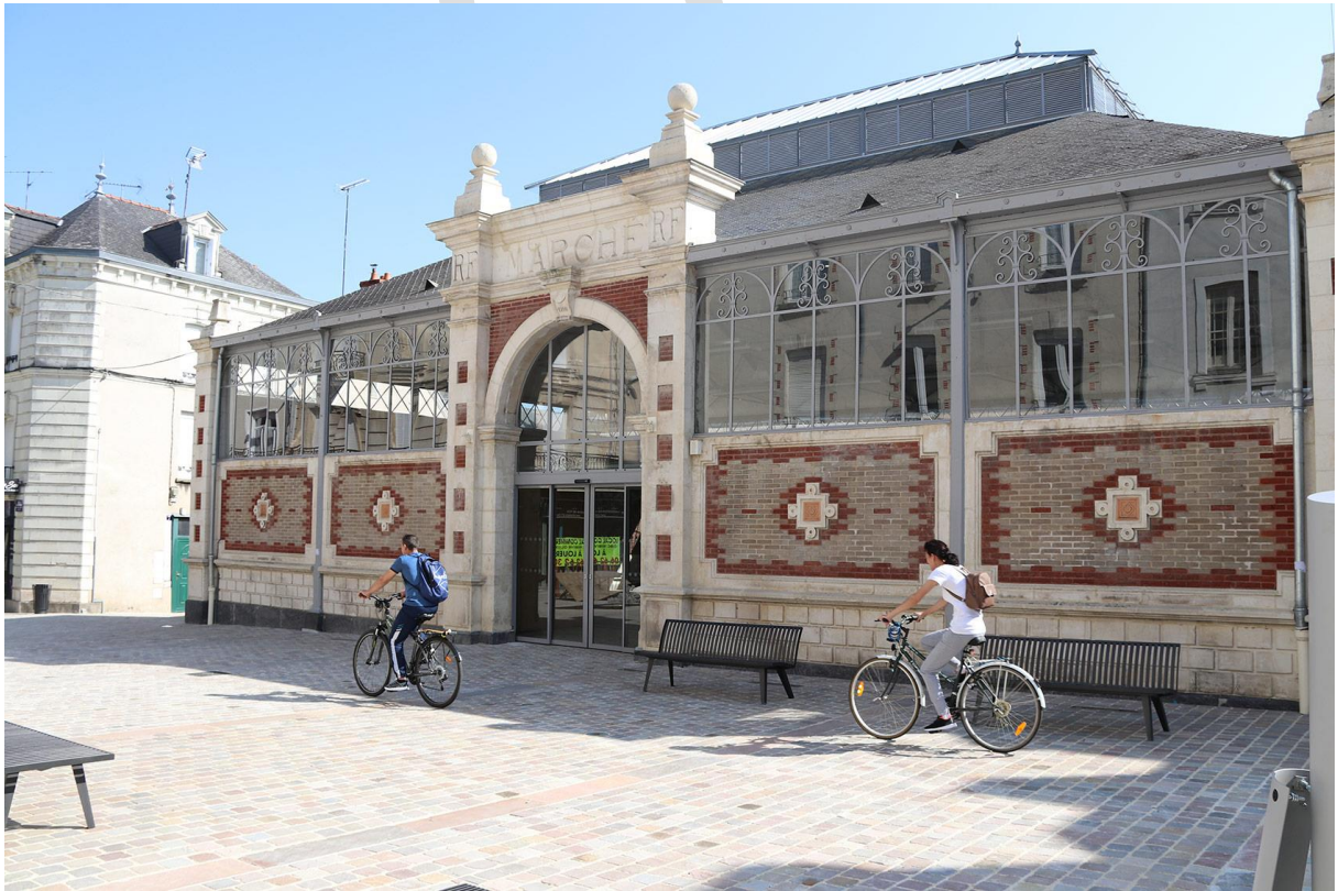
Vue sur le marché couvert rénové
