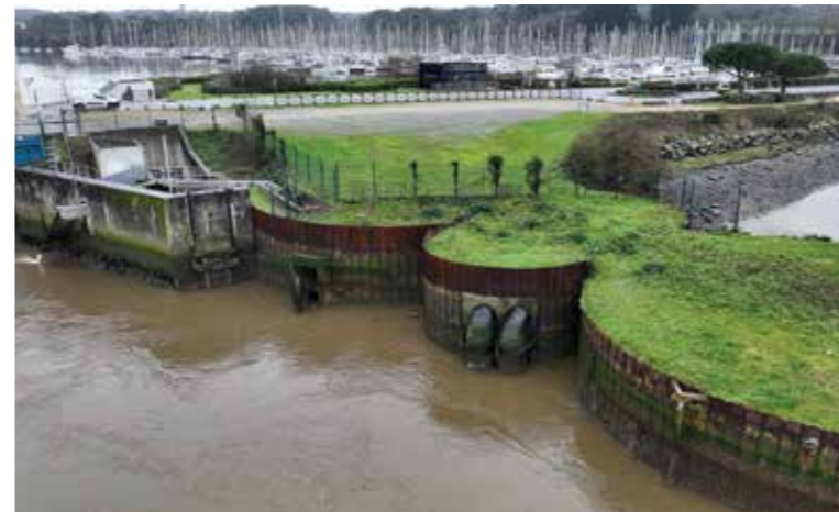
Gabions bientôt rénovés, barrage d'Arzal (56)
