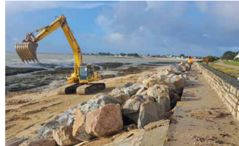
Enrochement de la digue de la grande place de Damgan (56)
