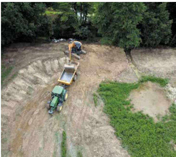
Remblaiement d'un des plans d'eau pour recréer une zone humide
