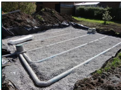
Figure 2: Exemple d'installation en chantier
