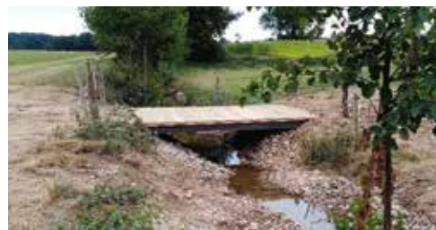
Passerelle qui permet le franchissement des bovins du ruisseau de la Planche Cleuze (Saint Sulpice des Landes 35)
