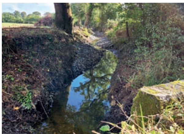
Jans. Ruisseau des trente roches (Don), travaux morphologiques
