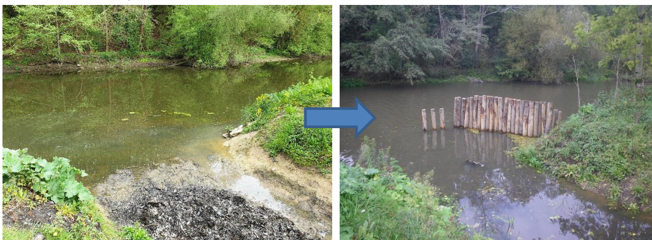
Peigne végétal à l'entrée de la frayère de la Mondrais sur la commune de Pléchatel (35)
