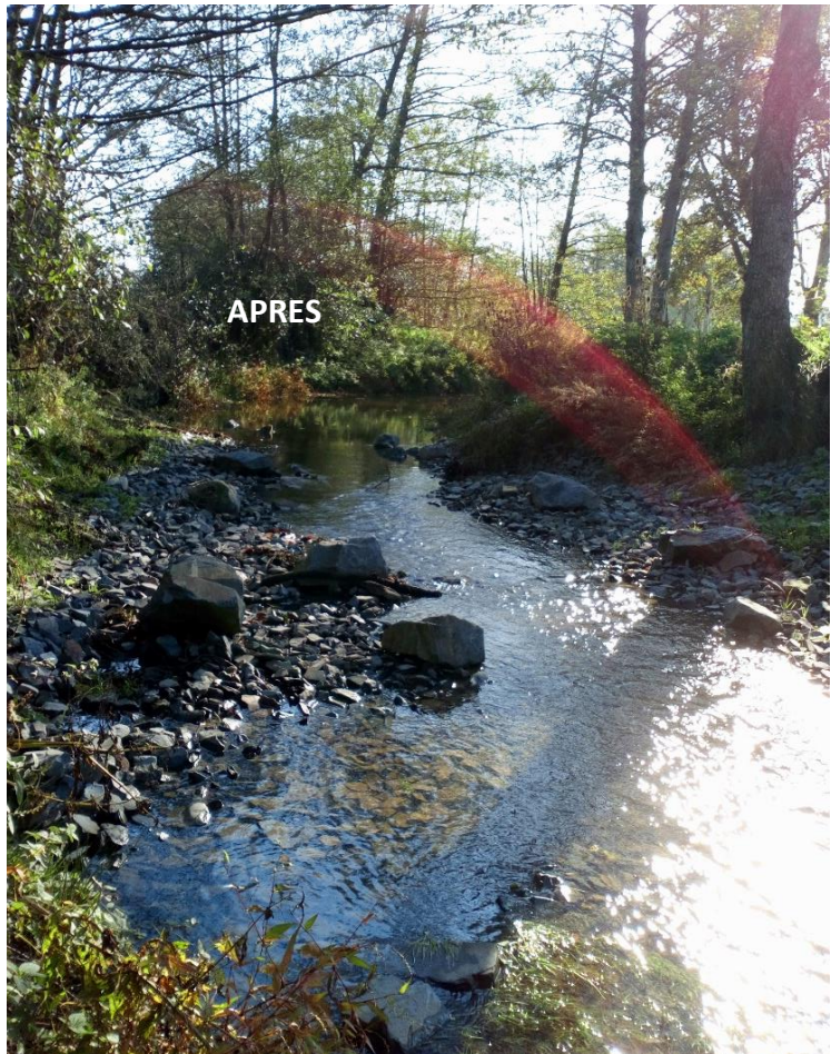
Travaux de création de radiers-dômes sur 1000 ml du cours principal du Semnon en amont de l'ancien moulin du Gravier à Eancé (35)
