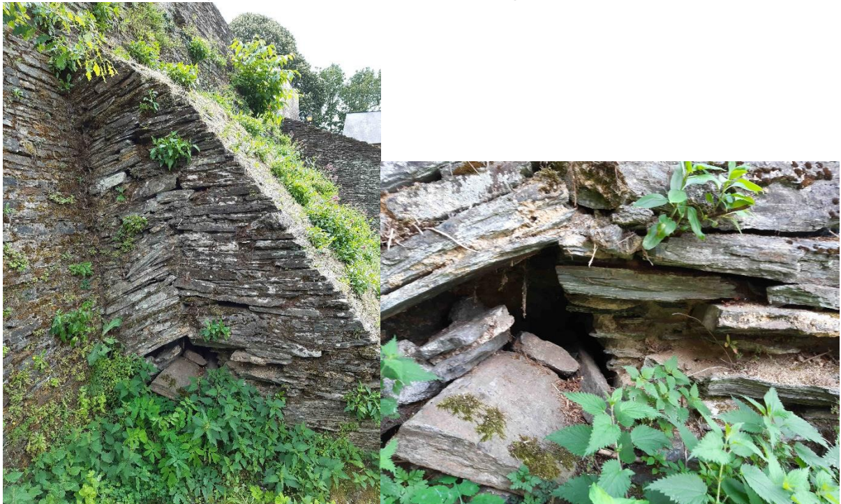
Point 11 : Lacunes de pierres de schistes avec cavité importante
