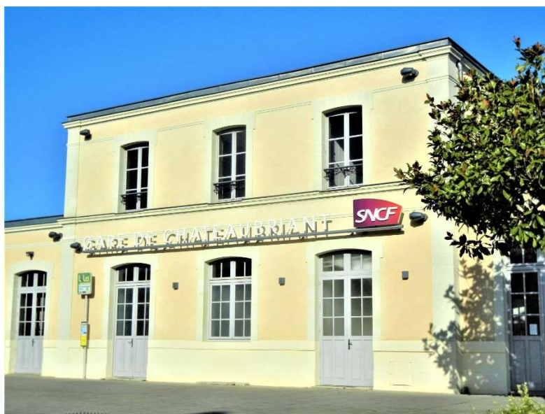
La gare de Châteaubriant a été rénovée en 2014
